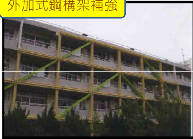
外加式鋼構架補強
