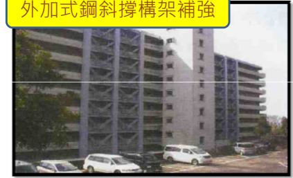
外加式鋼斜撐構架補強
