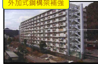
外加式鋼構架補強
