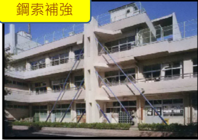
外加式鋼構架補強
