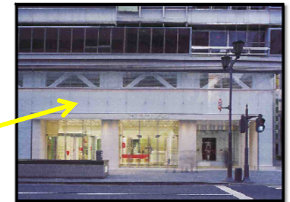
外加式鋼斜撐構架補強
